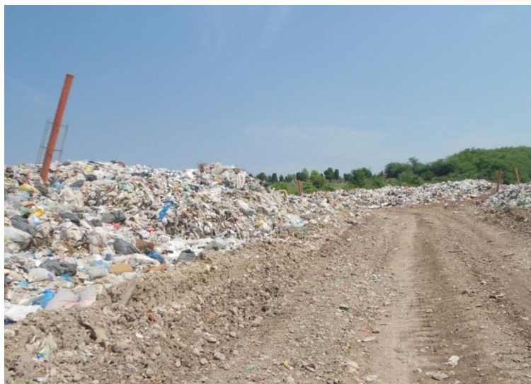
Слика 4.6 - Пасивни ситем за дегазацију депонијског гаса на несанитарној депонији "Бубањ" у Нишу
