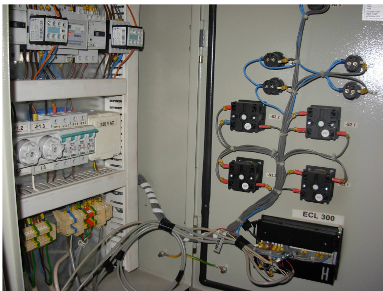
Слика 4.6 Унутрашњост разводног ормана са Danfoss ECL Comfort 300 регулатором
