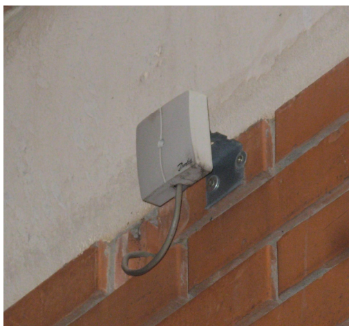
Слика 4.17 Danfoss ESMT сензор спољне температуре
