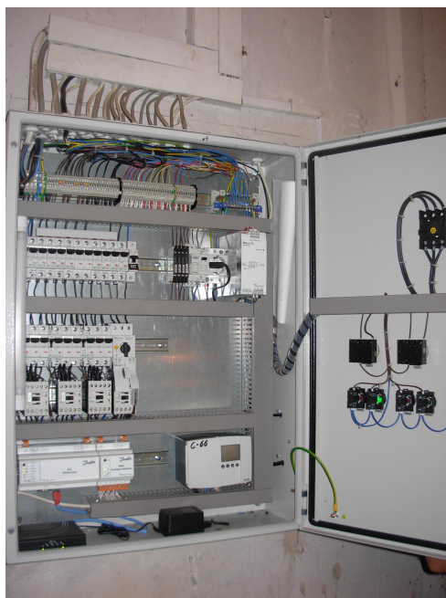
Слика 4.14 Разводни орман са регулятором Danfoss ECL 300 и интегрисаном програмском картицом C66
