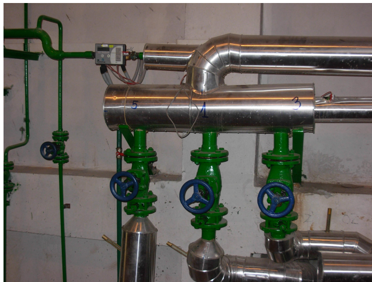
Слика 4.10 Начин мешања воде из потиса дистрибутивне мреже и повратне воде из инсталација корисника
