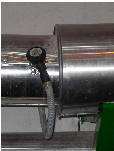
Слика 4.16 Danfoss ESMU 100 урањајући сензор температуре
