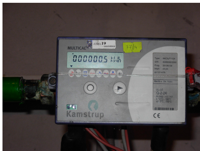
Слика 4.15 Ултразвучни мерач протока Kamstrup – Multical 66CDE
