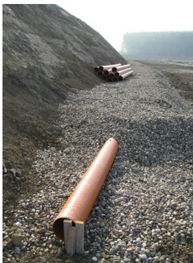
Слика 5.8 Постављање цеви за дренажу подземних вода на депонији
