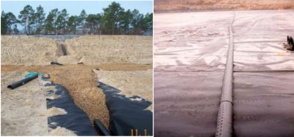
Слика 5.11 Изглед дренажних цеви за сакупљање процедних вода [54]
