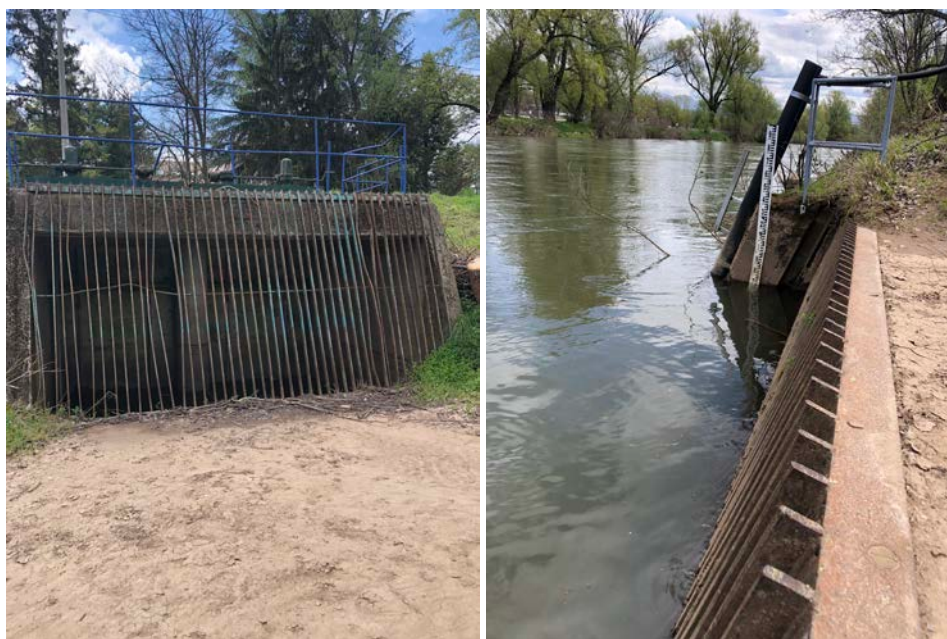
Слика 5-3 Водозахват речне воде у зони изворишта „Медијана“ за мерно место Ниш (лево) и водомерна летва на локацији водозахвата (десно)
